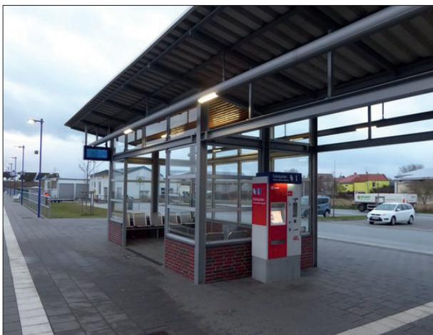
**Abbildung 12:** Auch mehr als acht Jahre nach Inbetriebnahme ist die Wartehalle in Fehmarn-Burg in einem guten Zustand. Allerdings ist auch hier bereichsweise Algenbildung an der Dachunterseite zu beobachten.
