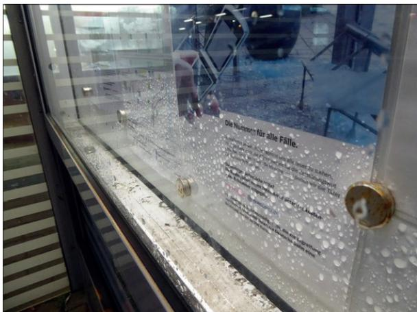
**Abbildung 35:** An Gleis 1 in Elmshorn waren die Vitrinen in den Unterständen zum wiederholten Mal innen nass.
