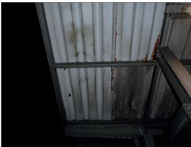
**Abbildung 9:** Unter der bereichsweise entfernten Tropfschutzfolie der Wartehalle in Morsum ist Rostbildung an der Dacheindeckung zu erkennen.
