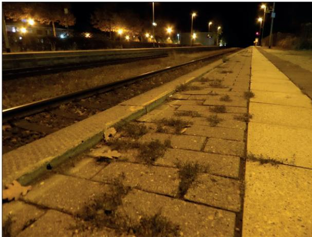
**Abbildung 4:** Am Bahnsteig für Gleis 2 in Preetz gibt es bereichsweise Absackungen mit Stufenbildung von 2-3 cm Höhe vor der Bahnsteigkante.
