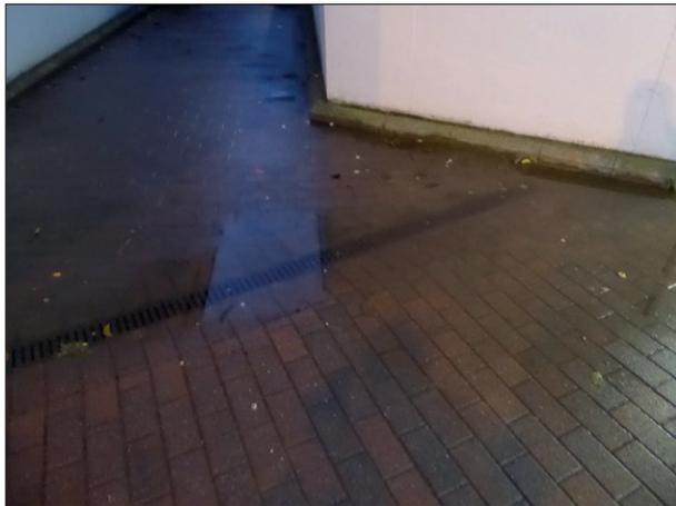
**Abbildung 46:** In Keitum war die Entwässerungsrinne am Fuß der Treppe zu Gleis 2 verstopft. Es kam zur Bildung einer großen Pfütze.
