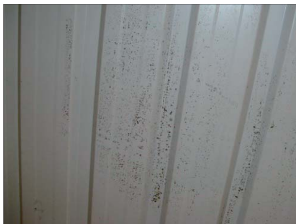
Abbildung 52: An der verkleideten Tunneldecke in Rendsburg hat sich stellenweise Schimmel gebildet.
