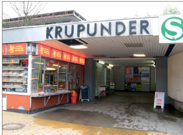
Abbildung 43: Im Eingang des Bahnhofs Krupunder war das Dach undicht. Einige Teile der Deckenverkleidung wurden bereits entfernt.
