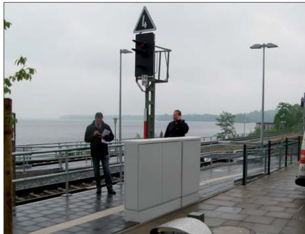
Abbildung 44: Mitten in den neuen Zugang zum Gleis 2 wurde in Plön der neue Elektro-Schaltschrank gebaut.
