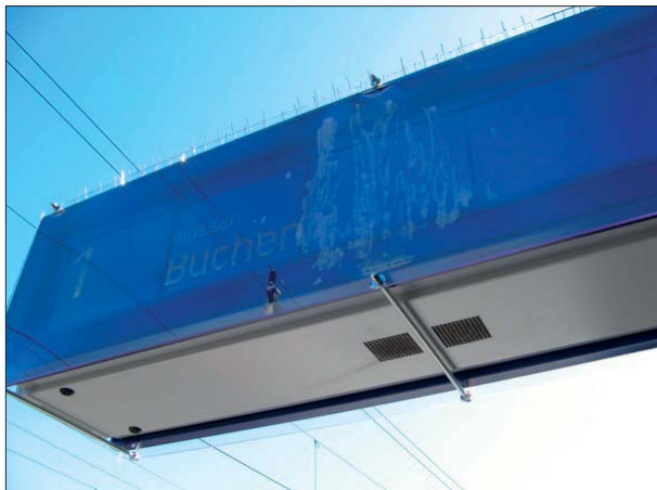
Abbildung 50: Zwischen dem Zugzielanzeiger und der Vandalismus-Schutzscheibe hat sich in Schwarzenbek stellenweise Wasser angesammelt.
