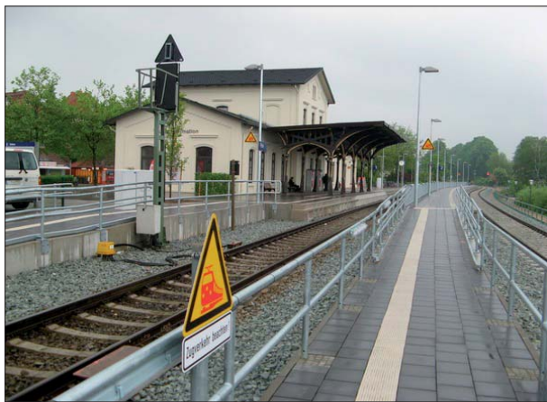
Abbildung 2: In Plön wurden der Hausbahnsteig erhöht und ein neuer Zwischenbahnsteig mit ebenerdiger Gleisquerung und Rampenzugängen errichtet.
