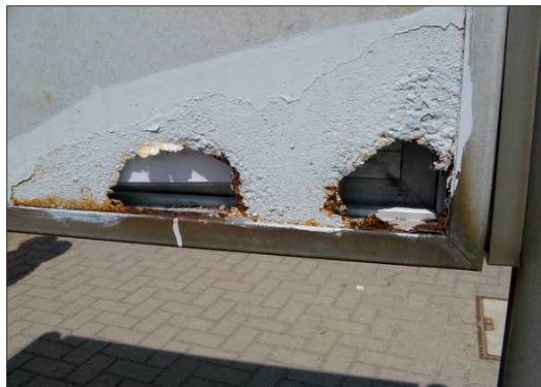
Abbildung 30: Die neue Farbe an der durchgerosteten Vitrine am Gleis 2 von Herzhorn zeigt, dass das Problem erkannt wurde. Sie löst es aber nicht.
