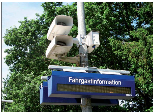
Abbildung 27: Bei der Ausstattung mit den DSA wurden meist auch zusätzliche Lautsprecher installiert. Das sieht teilweise nicht sehr durchdacht aus, wie hier in Burg (Dithm).
