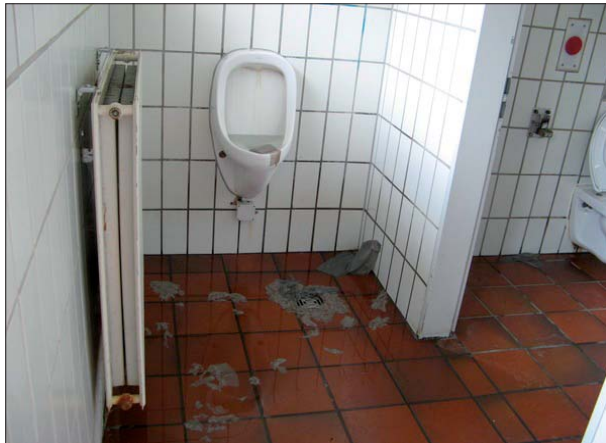
Abbildung 38: Durch automatisches Spülen und Verschmutzung des Urinals mit Papierhandtüchern stand das Wasser im Herren-WC von Haffkrug zentimeterhoch.
