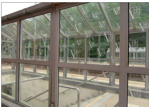
Abbildung 24: Um dem Zerkratzen und Beschmieren der Scheiben vorzubeugen, wurden die Treppeneinhausungen in Bad Schwartau mit Stadtwappen-Folien beklebt.
