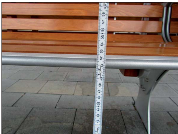
Abbildung 12: Die meisten der in Rendsburg neu installierten Sitzbänke sind rund 5 cm zu hoch montiert worden. Die Sollhöhe beträgt 45 bis 46 cm.
