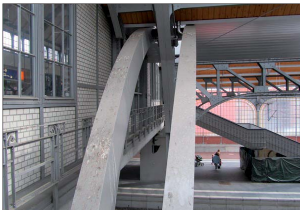
Abbildung 9: Die Tauben im Bahnhof Lübeck haben unter anderem einzelne Stützen der Hallenkonstruktion stark verschmutzt.
