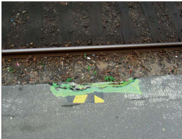
Abbildung 5: Der Bahnsteig in Wedel weist besonders an den Kanten weitere Schäden auf.
