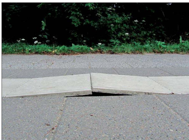
Abbildung 6: Einzelne Platten des im letzten Jahr erneuerten Blindenleitstreifens in Haffkrug waren offenbar aufgrund fehlender Dehnungsfugen angehoben.
