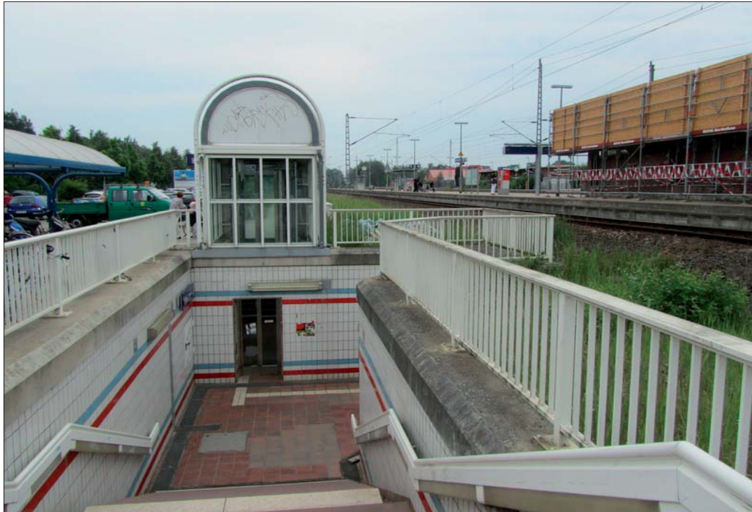
Schwarzenbek: Bahnhof an der Strecke Hamburg - Büchen: Der abgebildete Aufzug zur Bahnhofsrückseite war in Betrieb aber beschädigt. Die untere Aufzugstür schloss mit einem lauten Knall. Der Aufzug zum Gleis 1 war defekt, und davor stand Wasser im Tunnel.
