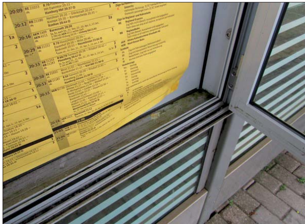
Abbildung 28: In die Vitrine eines Fahrgastunterstandes in Elmshorn drang trotz der Überdachung Wasser ein.
