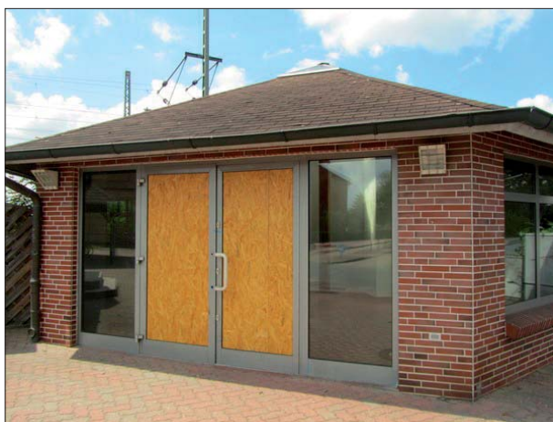
Abbildung 36: Der Warteraum im Pavillon von Owschlag stand zur Verfügung. Die beschädigten Türscheiben waren provisorisch durch Spanplatten ersetzt worden.
