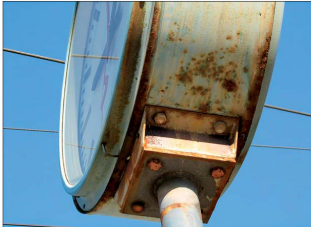
Abbildung 19: Diese Uhr in Neumünster weist zunehmende Korrosionsschäden auf.
