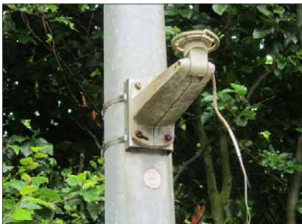
Abbildung 27: In Brokstedt fehlten an Gleis 2 zwei Lautsprecher.
