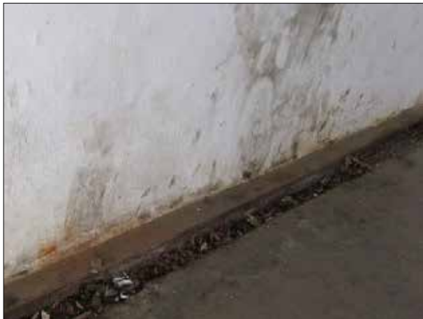
Abbildung 43: Im Tunnel von Bad Malente-Gremsmühlen war die Wasserablaufrinne bereichsweise nicht abgedeckt.
