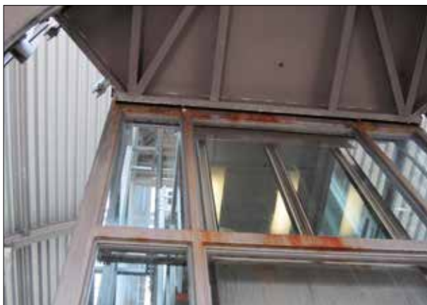
Abbildung 45: An der Aufzugseinhausung in Kaltenkirchen haben die Rostschäden zugenommen.
