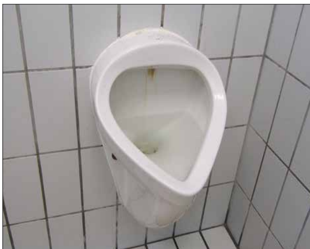
Abbildung 39: Das Herren-WC in Bad Schwartau stand durch dieses verstopfte Urinal unter Wasser.
