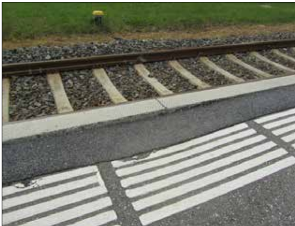
Abbildung 4: Der Bahnsteig in Dagebüll Kirche ist im Bereich der Bahnsteigkante trotz im letzten Jahr erfolgter Ausbesserung stellenweise schon wieder abgesackt.
