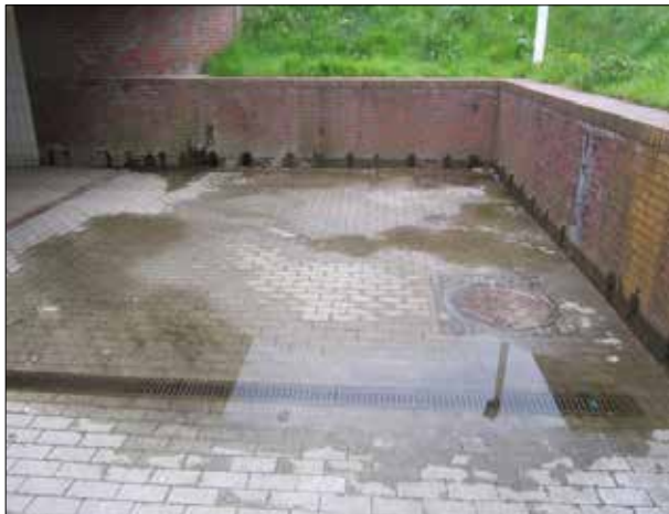
Abbildung 44: Diese Ablaufrinne am Tunnelzugang in Schleswig war offensichtlich verstopft.
