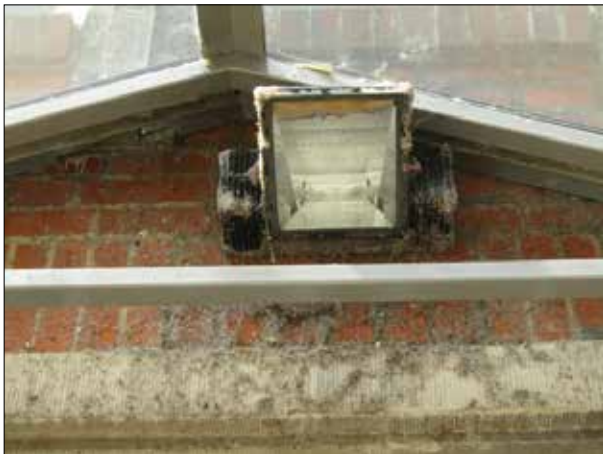
Abbildung 8: Auffällig verschmutzt war der Bereich um den Strahler unter dem Bahnsteigvordach in Bad Schwartau.
