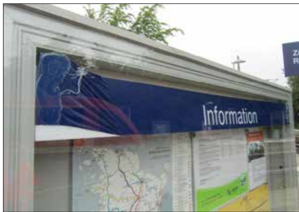
Abbildung 32: In Einfeld lösten sich die nachträglich in die Vitriken eingeklebten Reiter durch Sonneneinstrahlung von den Scheiben.
