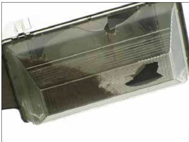
Abbildung 47: Durch die Beschädigung der Haube ist diese Bahnsteiglampe in Gokels von innen erheblich verschmutzt.
