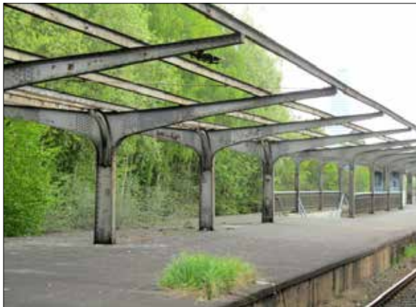
Abbildung 53: Durch das vollständige Entfernen der Dachhaut beeinträchtigen die Reste des alten Bahnsteigdachs verstärkt das Erscheinungsbild in Travemünde Hafen.
