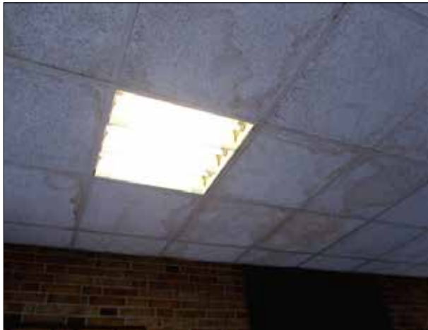
Abbildung 34: An den Deckenplatten des Warteraums in Gettorf sind die Wasserflecken unübersehbar.
