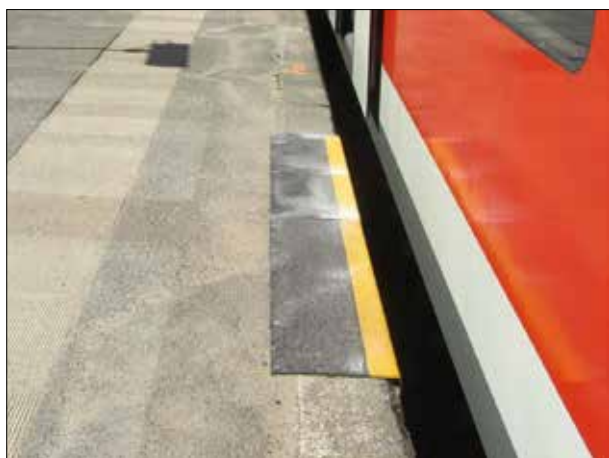
Abbildung 51: Die bröckelnden Bahnsteigkanten in Wedel wurden stellenweise abgedeckt.
