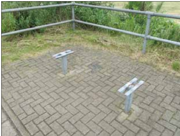
Abbildung 11: In Herzhorn wurden im letzten Winter die Bänke abgebaut. Während die Sitzgelegenheiten in den Unterständen wieder installiert wurden, stellen die Stützen am Gleis 2 ohne Bank eine Unfallgefahr dar.
