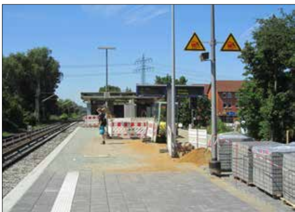
Abbildung 55: In Krupunder war der Bahnsteig Ende Mai schon in weiten Teilen erneuert. Die Sanierung des Zugangsbereichs mit dem Aufzugseinbau stand noch bevor.
