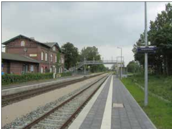
Abbildung 1: In Lunden wurde der alte Zwischenbahnsteig durch einen Außenbahnsteig mit Fußgängerbrücke ersetzt. Ein barrierefreier Zugang besteht vom Bahnübergang aus.
