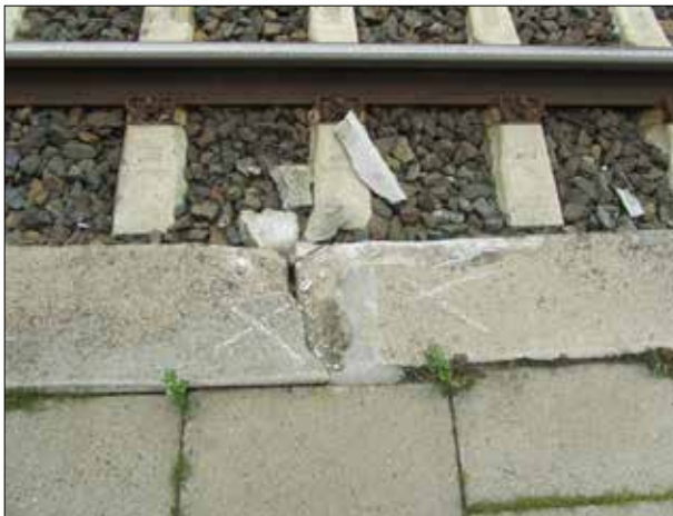
Abbildung 5: Der Bahnsteig am Gleis 1 in Flintbek weist an der Kante zunehmend Schäden auf.
