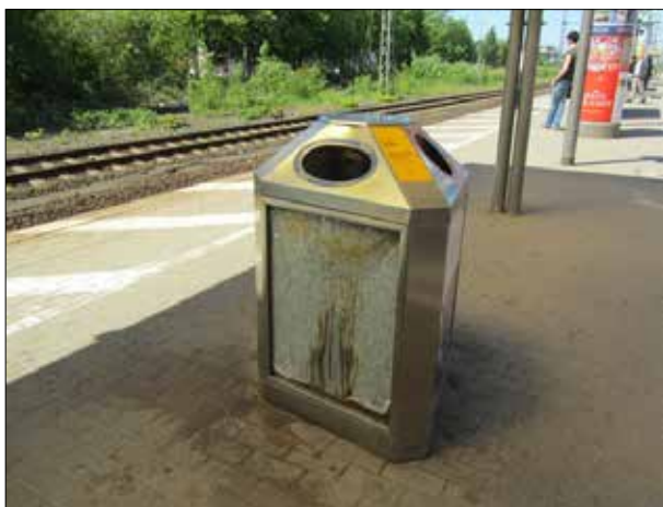
Abbildung 15: Der Müllbehälter an den Gleisen 4 und 5 in Pinneberg wies Rostschäden auf.
